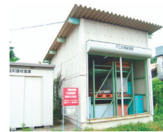
PCB廃棄物保管倉庫
